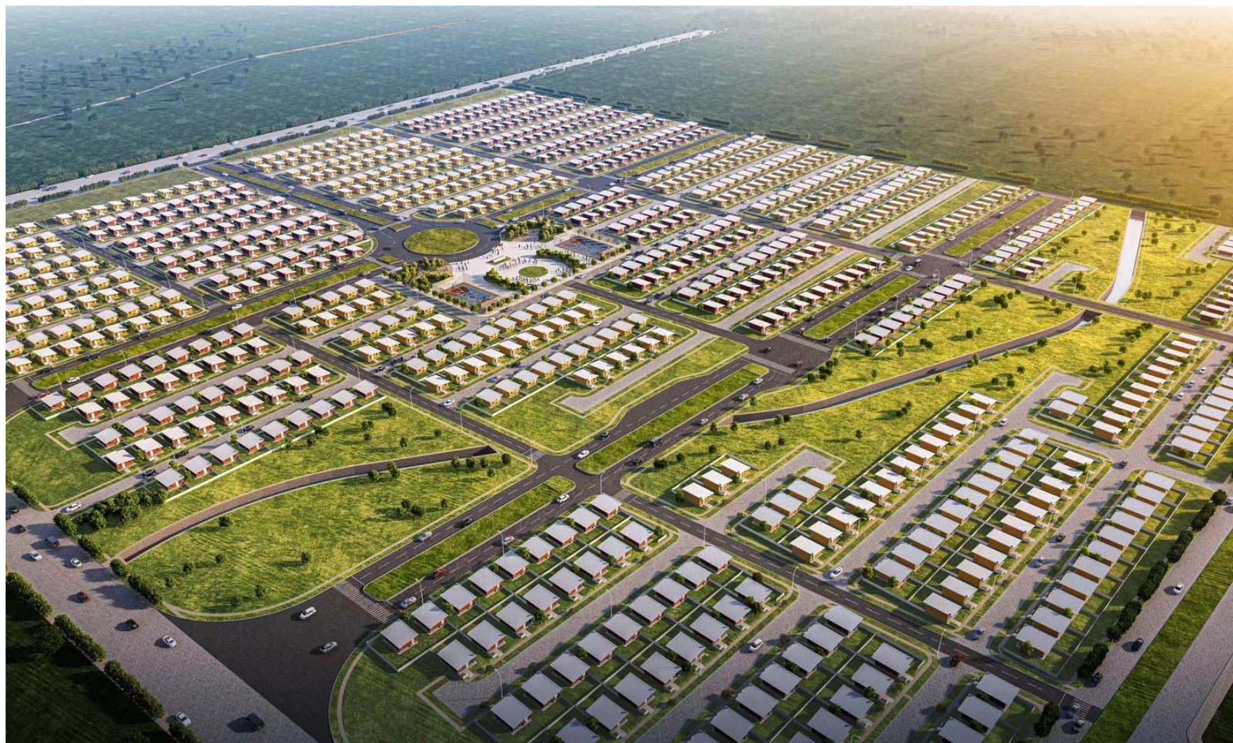
Proyecto Urbanización Nuevas Victorias en Managua (920 viviendas).
