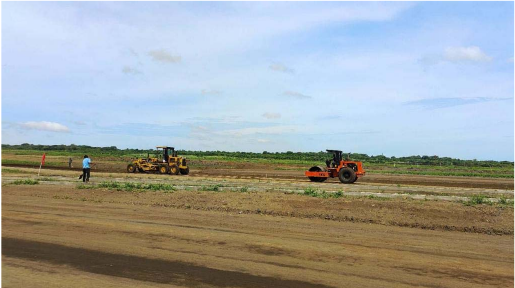
Actividades de Movimiento de Tierra.
